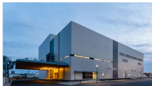
第一三共 製剤設備
