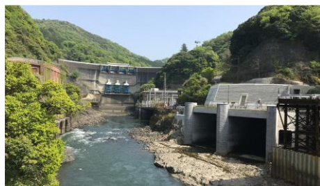
天ヶ瀬ダムトンネル式放流設備
